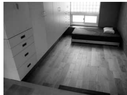
逆梁構造を活かして床面を一段下げ、空間を広げている。
